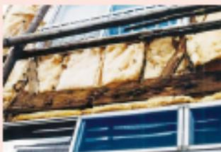
経年の水分の吸収と自らの重さでスレ落ちた繊維系断熱材の例
