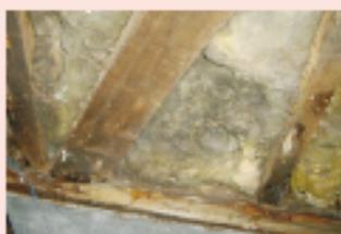
結露が木(構造体)を腐らせ、建物の性能を著しく低下させている劣化具合の例
